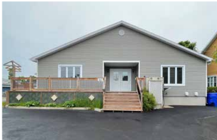
Résidence de la Rive à Montmagny
